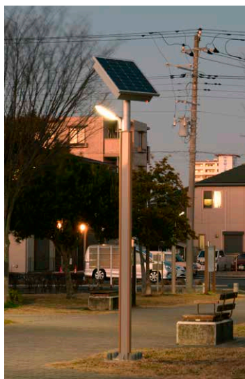
蓄電池を上部に配置した 浸水に強いデザイン
